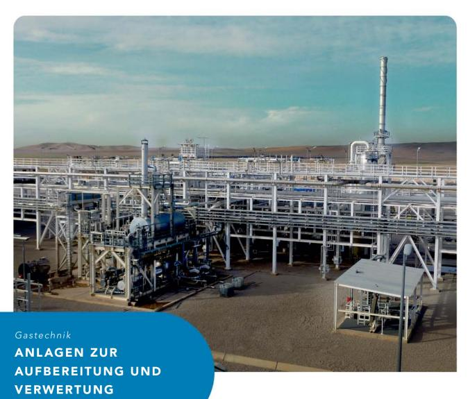
Diese Anlagen finden Verwendung im Bereich der Erdölförderung, um aus parallel anfallenden Gasen Wertstoffe zu gewinnen. Dabei muss in einem ersten Schritt der Taupunkt des Gases durch zum Beispiel Glykoltrocknung eingestellt werden. Im Weiteren können Produkte wie Gaskondensat und LPG vom Gas durch spezielle
